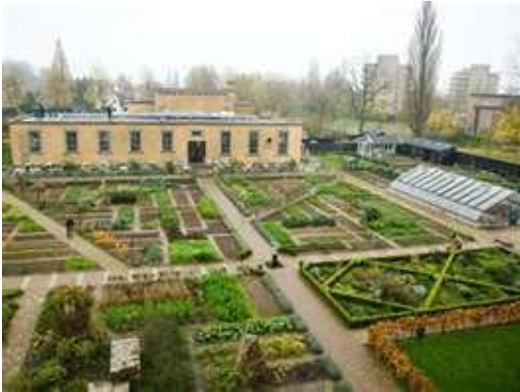
Blik vanuit de Watertoren op een deel van de tuin en op het oude pompegebouw, waar nu het restaurant en marktcafé in zitten (bron: www.villa-augustus.nl )
